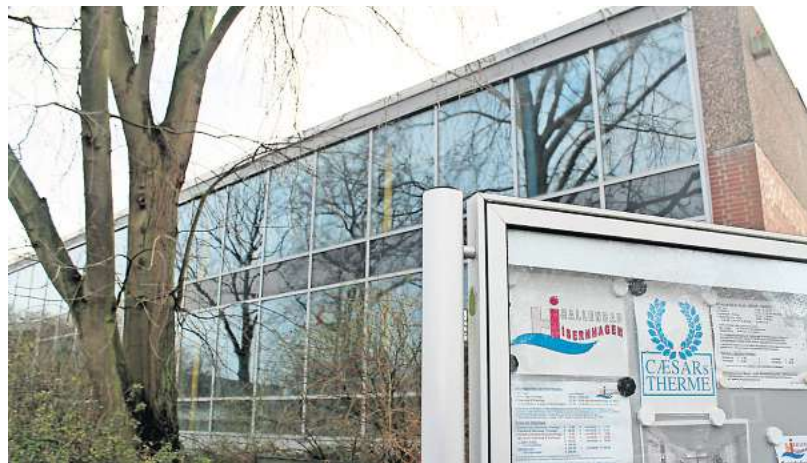
1975 eröffnet: Das alte Hallenbad müsste laut Gutachten in drei bis fünf Jahren für einen Millionenbetrag saniert werden.
